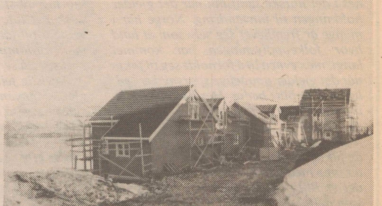
Ørndalen-prosjektet (bildet) gir 350 Tromsø-studenter et sted å bo.
