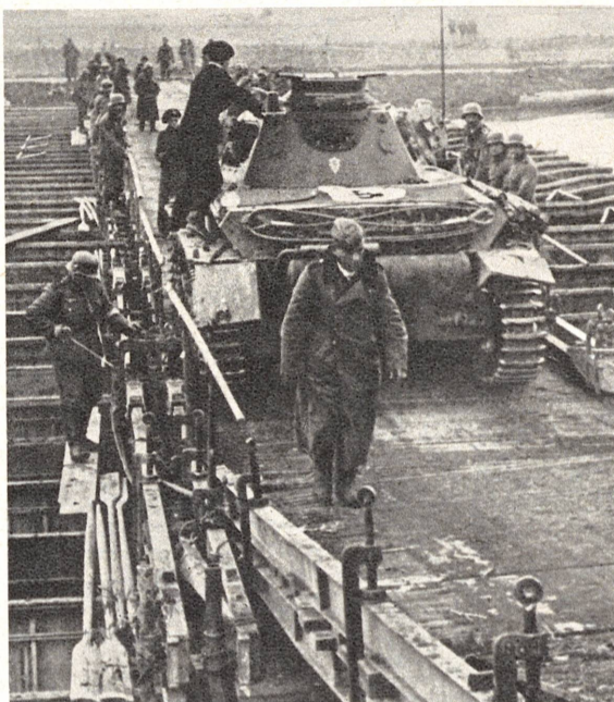
„Heller ikke de tallrike vannløp som måtte overvinnes av tyskerne kunde opholde dem under deres forfølgning av motstanderen. . .“ Panserkampvognen kjører over en krigsbro som er bygget av pionerene
