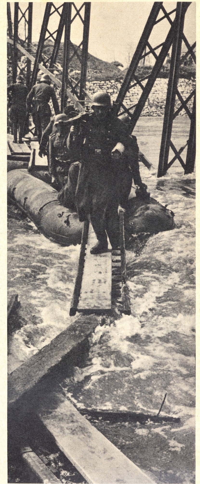
Gummi i stedet for jern. Av gummibåter har pionérene bygget en nødbrø over elven Drau i stedet for en ødelagt bro. Etter ti minutter fortsetter fremrykningen. Bildet ne- denfor: Den lar sig kjøre. En tanksleper „bærer“ den store panservogn frem til utgangsstillingen for angrepet frem til fienden
