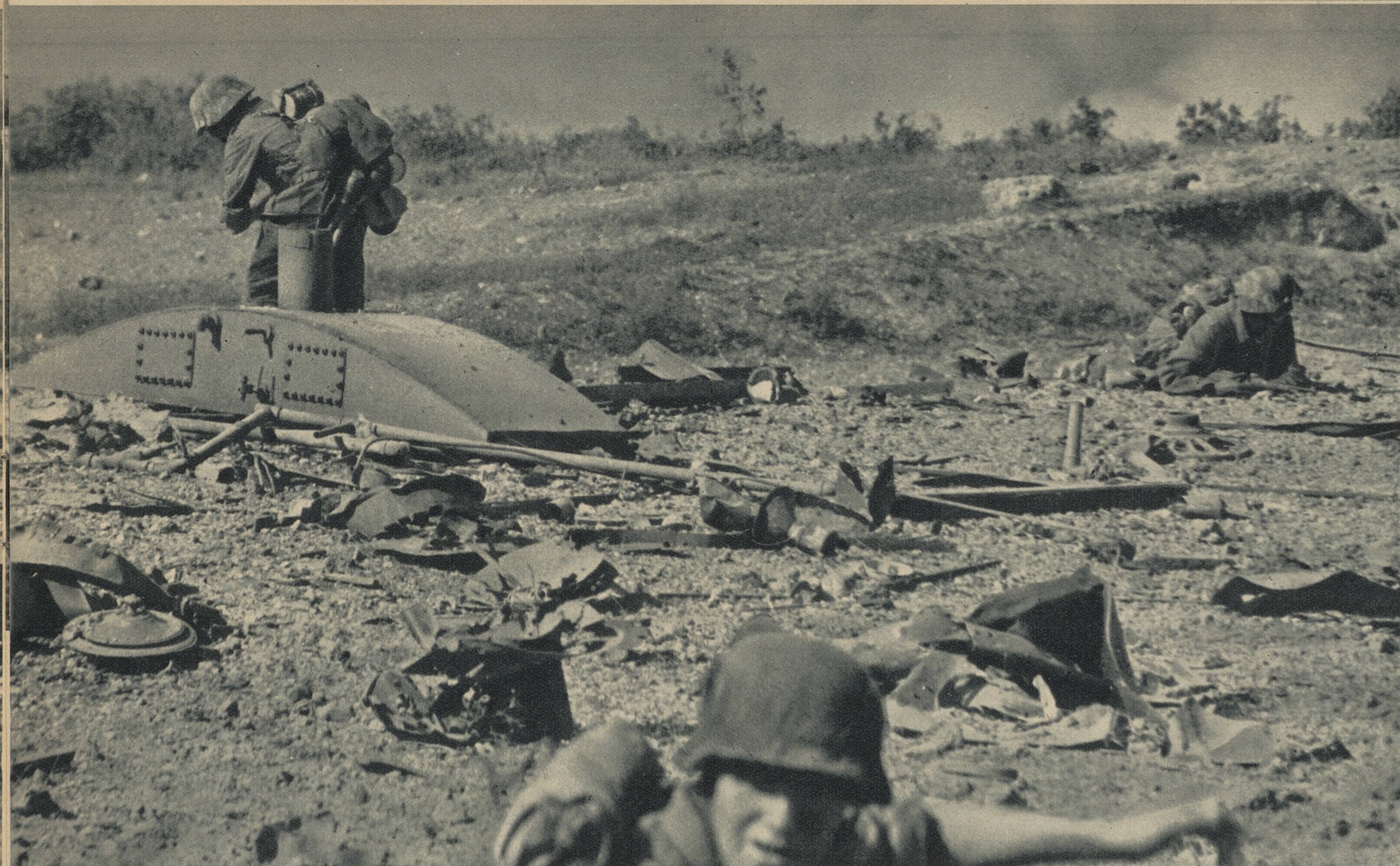
Bunkerstilling på jernbanefjellet — etter stormangrepet
