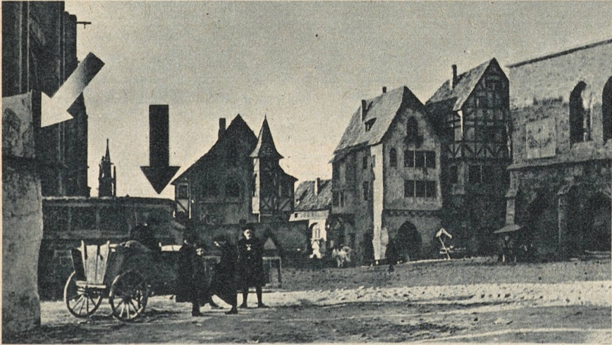
Middelalder — bygd 1942. Filmarkitektene har løst den vanskelige oppgave, en by fra renessansens dager ble trykelt fram av jorden. Høye bindingsverkshus lager vinkelsmug, som munner ut på torget, som til venstre flankeres av domkirken og til høyre av universitetet. Enno ligger byen død i den oppgående sol. Men snart vil fargerikt liv fylle plassen og smugene, for i dag er det første innspilingsdag. — Pilene viser, hvor kameraet og mikrofonen begynner sitt arbeid.
