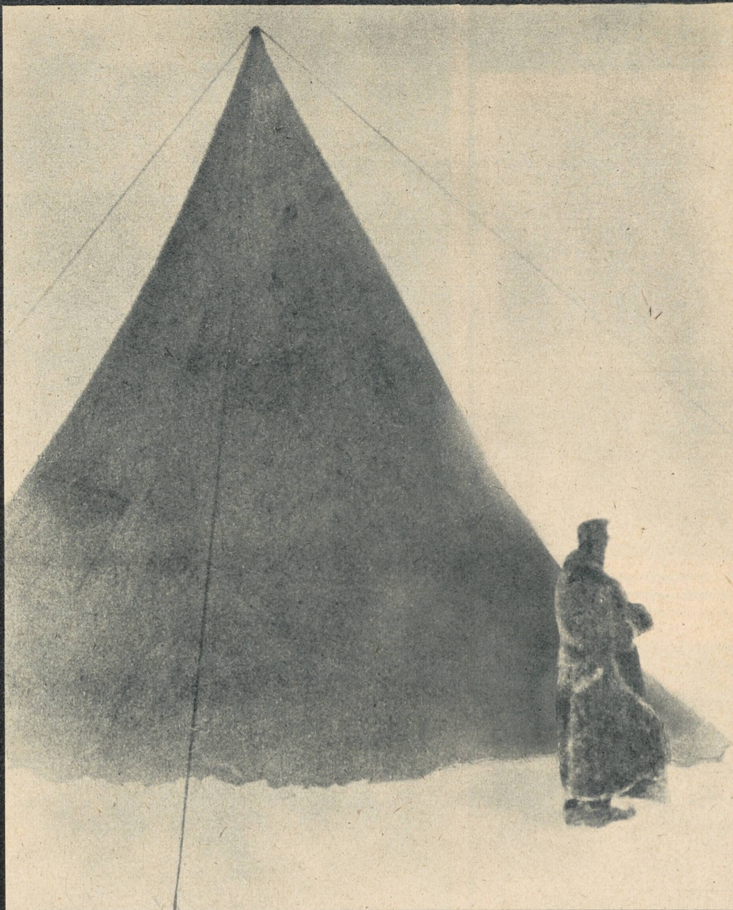
En av nordfrontens spesialiteter: stormfeltet. Det er bestemt for framskutte poster og rommer lyve mann. Det oppvarmes av en jernovn. Når det trekkes opp til snøstormer, kan det settes opp med noen få håndgrep
