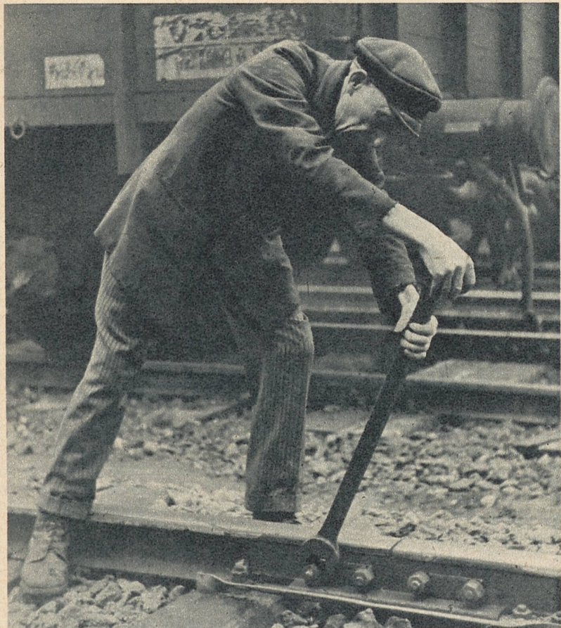
Joseph B., tidligere møbelsnekker, no jernbanearbeider i et stort stålverk i Vest-Tyskland. „Jeg arbeider mine tolv timer om dagen som en ungdom“, forteller han, „for jeg har vært arbeidsløs lenge og vet hva som bedre er . . .“
