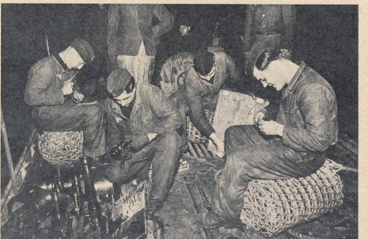
20 Også en del av besetningen oppholder seg til stadighet i nærheten av båten og hjelper til med reparasjonene. Her sitter maskingastene på fenderne, fjerner rusten av maskindelene og maler dem over med ny beskyttelsesfarge
