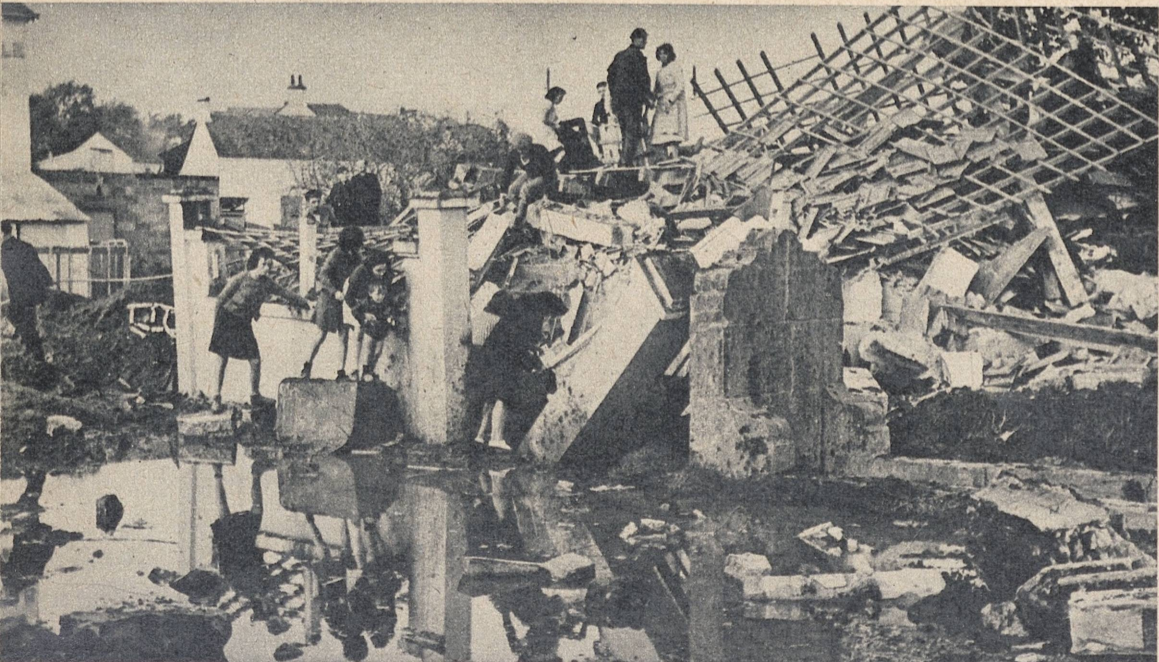
17 Metertykke vegger og tak av jernbetong beskytter u-båtene i bunkerne mot engelske bombeangrep. Engländerne kommer riktignok stadig på ny, men det er hver gang bare den franske sivilbefolkningens hus som faller som offer for bombene
