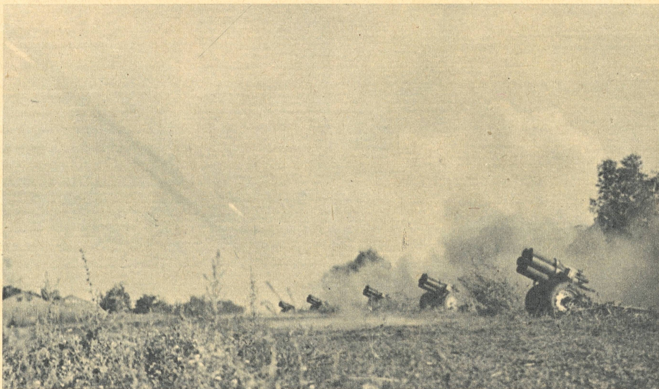
Kanoner uten mannskap? De seks granater i hver kaster blir fyrt av ved elektrisk tenning av betjeningsmannskapet, som er gått i dekning ca 20 meter bak kanonene. Den nye drivmåten til dette våpens prosjektill gjør at batteriene hylles inn i røyk og støv PK-fotos: Krigskorrespondent Walz
