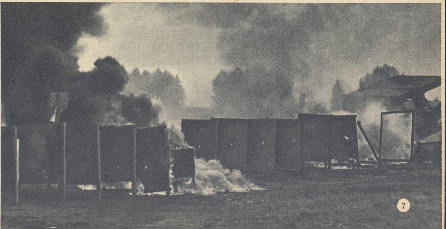
**Bei der Luftwaffe.** Geschosse von Bordwaffen durchschlagen eine Reihe von Panzerplatten, um erst danach, entsprechend einem Flugzeugintern, zu explodieren
