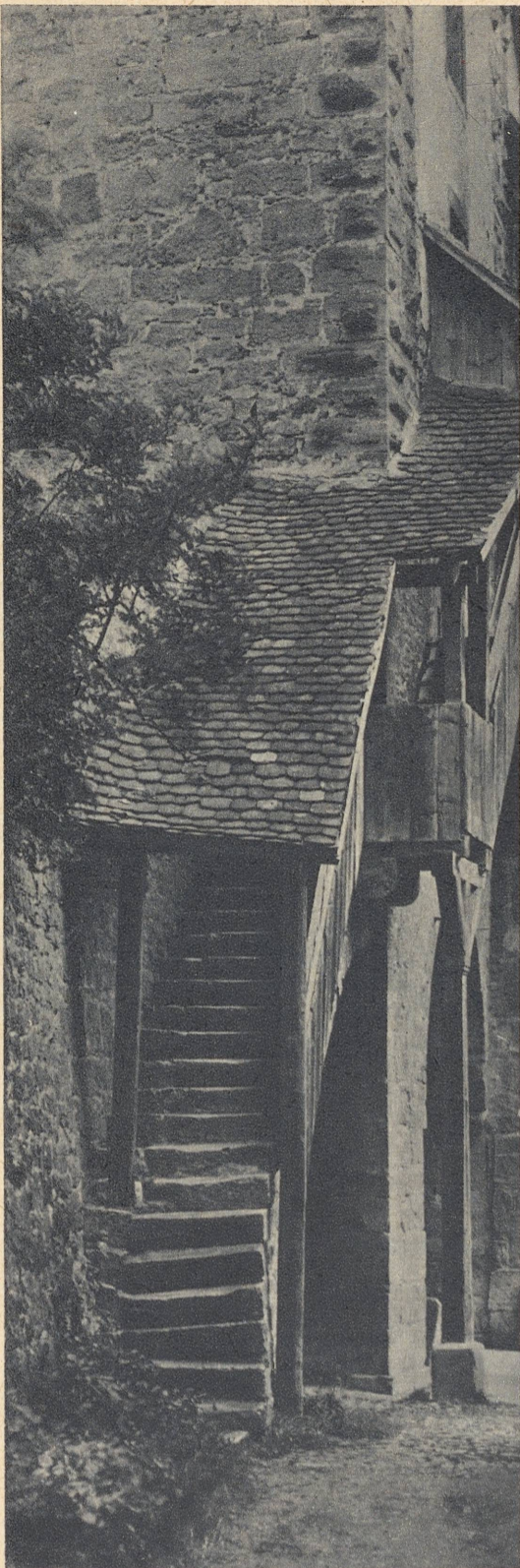
Oppgang til forsvarstårnet i Rothenburg o. d. T. De tildekkede trinnene går rundt tårnet utenpå.
