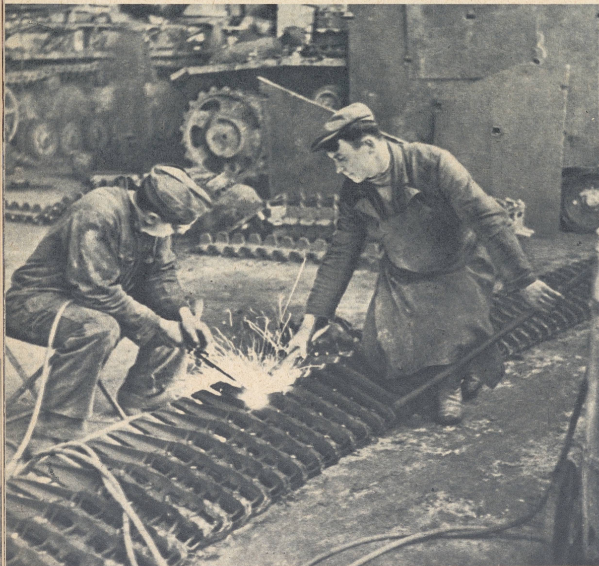
I et reparasjonsverksted, tett bak hovedkamplinjen, arbeider tyske faghåndverkere på å sette beskadigede pansere i stand igjen. Stedlige fabrikkarbeidere hjelper dem med å ta fra hverandre en larvekjede
